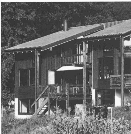
Überbauung Buchenweg. Detailsicht Südwesten
