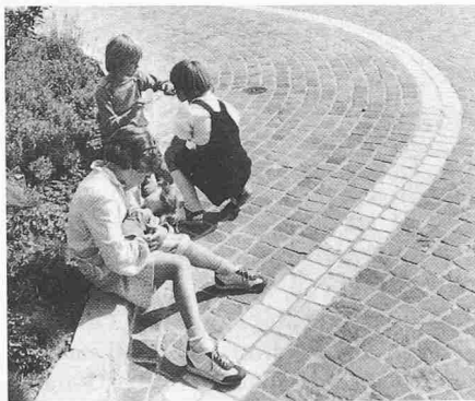
Wohnstrasse: Detailansicht der Natursteinarbeiten am Eichenplatz
