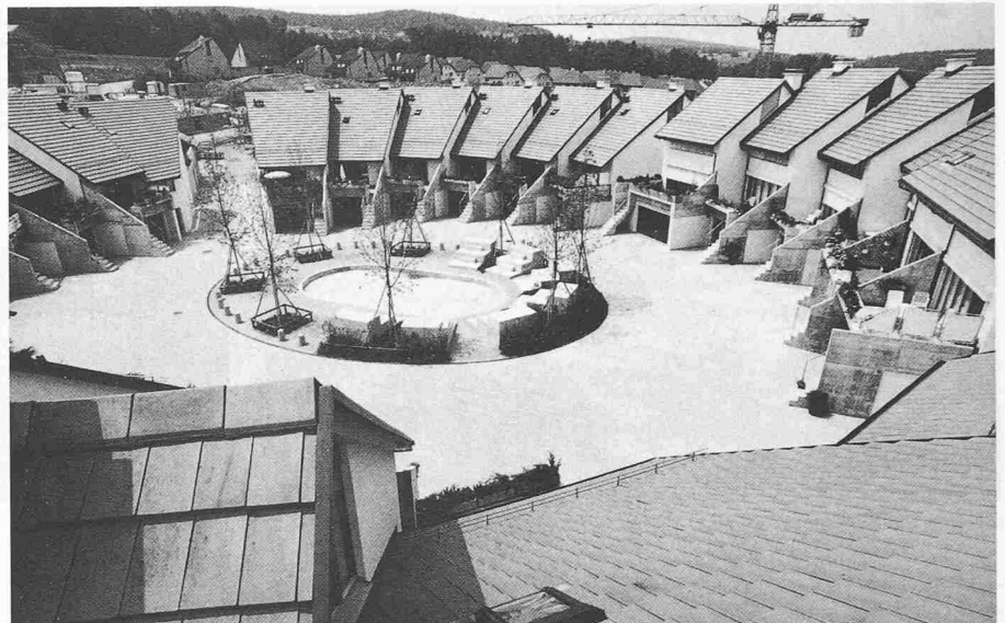
Überbauung Sonnenhof. Hofansicht mit Eingangspartie
