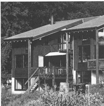
Überbauung Buchenweg. Detailsicht Südwesten
