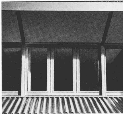
Bild 2. Ladenmodell A. Die Dämm-läden sind unter dem Vordach gut versorgt
