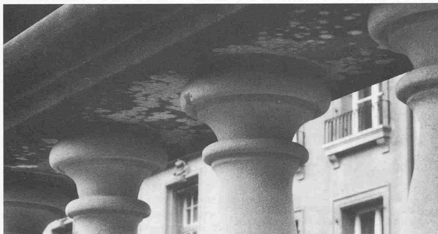
Bild 2. Detail der Untersicht Deckplatte Balustrade. Die weissen Ringe sind Algen und Pilze
