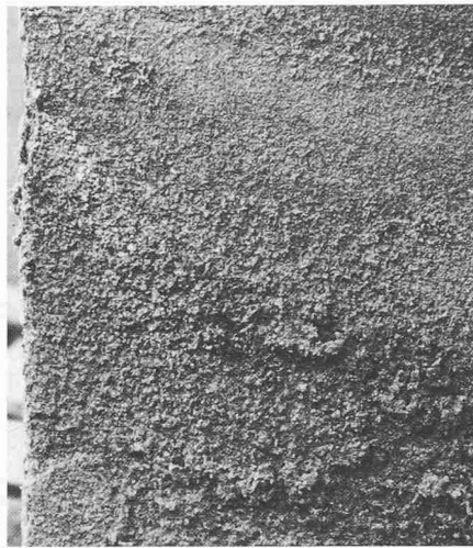
Bild 5. Stark absandende Partie (Bildbreite 10 cm). Der Sandstein zerfällt oberflächlich in Einzelkörner und stark gelockerte Kornaggregate
