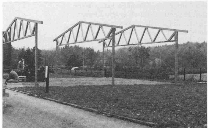
Bild 28 (oben). Prototypbau eines als Zweigelenkrahmen ausgebildeten Fachwerkbinders; Fachwerkträger mit Stäben aus Buchenbrettschichtholz; Knoten biegesteif
