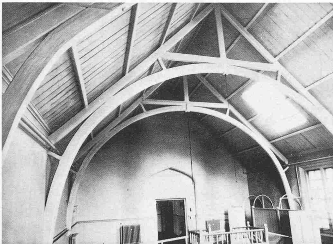
Bild 13. Bogenbinder aus Brettschichtholz; Versammlungssaal des King Edward College in Southampton, errichtet um 1860 (Foto: Arbeitsgemeinschaft Holz, Düsseldorf)
