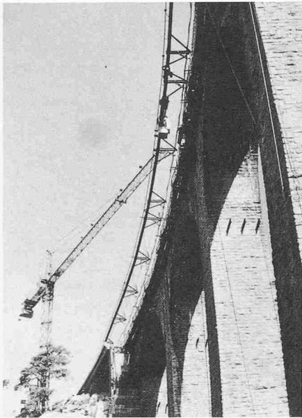
Bild 9. Monorail, seitlich am bestehenden Viadukt befestigt
