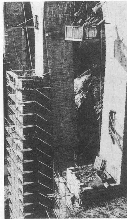
Bild 4. Verbreiterung der Pfeiler, Verbindung zu Verbundpfeiler Beton/Mauerwerk
