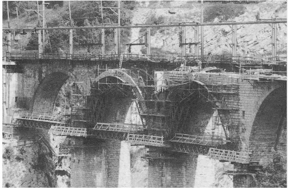
Bild 10. Lehrgerüst für den Überbau und Bauablauf
