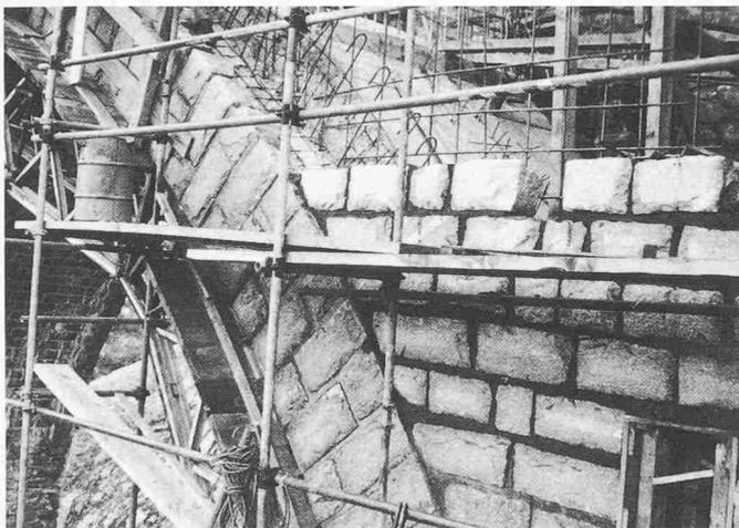
Bild 6. Mauerung der Bogenstirnseiten und der aufgesetzten Füllscheiben
