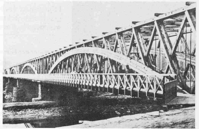
Bild 5 (rechts). Bogenverstärkter Howescher Träger über den Potomac bei Washington D.C. (aus [1] entnommen)
