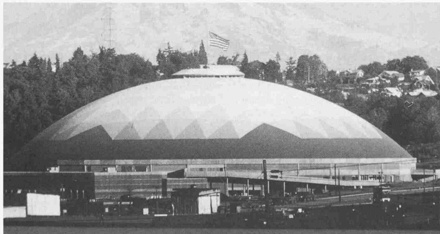
Bild 1. Holznetzschale in Tacoma, Seattle. Überdachung eines Sportstadions
