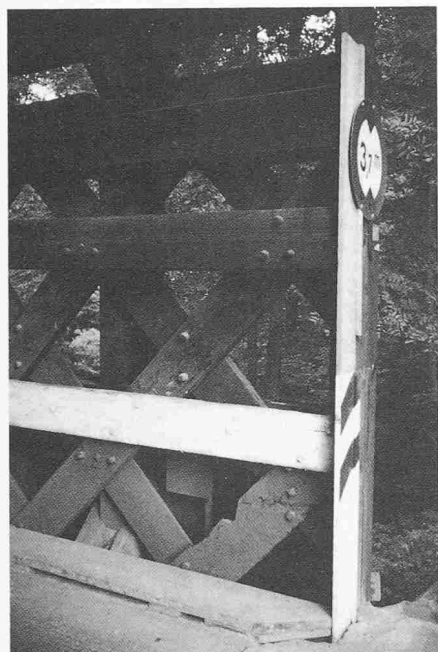
Bild 6. Townscher Träger über den Neckar bei Anzenwil
