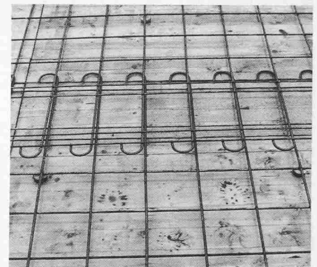
Bild 12c. Gut sicht- und kontrollierbarer Schlaufenstoss (450 mm)
