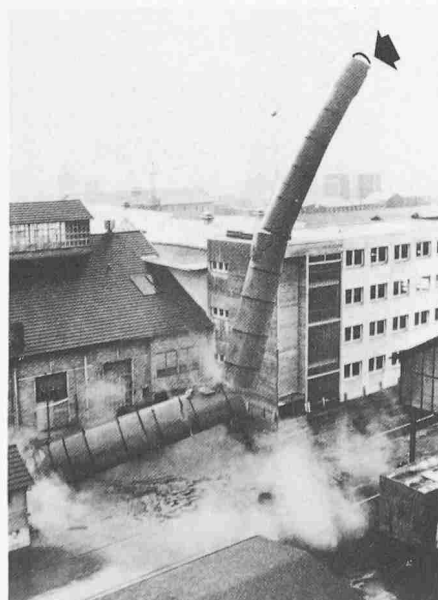
Bild 6. Wegschleudern des Gussrings
