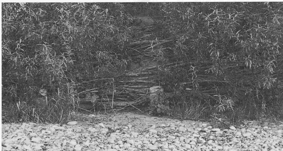
Die im Frühjahr 1982 versuchsweise ausgeführte Böschungssicherung. Der Lebendverbau war im Herbst 1982 bereits sehr gut verwachsen (Heimatschutzgesellschaft Winterthur)
