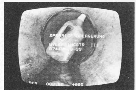
Bild 7. Kanalfernsehaufnahmen zur Beurteilung des Bau- und Betriebszustandes
