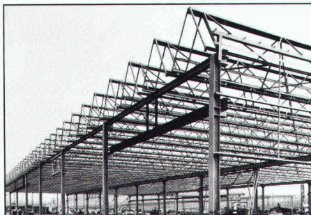
Metallstruktur eines Fabrikgebäudes mit Mini-Sheddach
