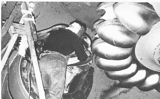
Bild 24. Arbeiten im Inneren einer Pelton-Turbine mit unzulässigen, improvisierten Beleuchtungseinrichtungen von 220 Volt; Einrichtungen für Kleinspannung fehlen hier
