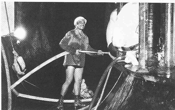
Bild 25. Arbeiten im Inneren einer Francis-Turbine mit unzulässigen mobilen Beleuchtungseinrichtungen von 220 Volt; Einrichtungen mit Kleinspannung fehlen hier
