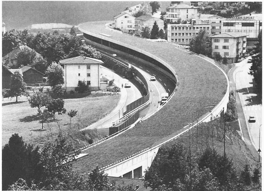
Bild 4. N2. Lärmschutzgalerie Hergiswil. Baulos 60. Blick Richtung Süden
