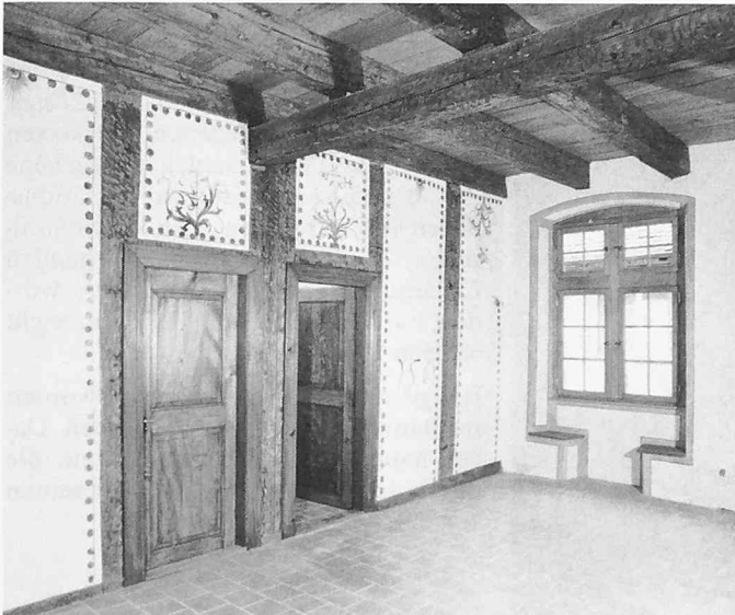
Halle im 2. Obergeschoss
