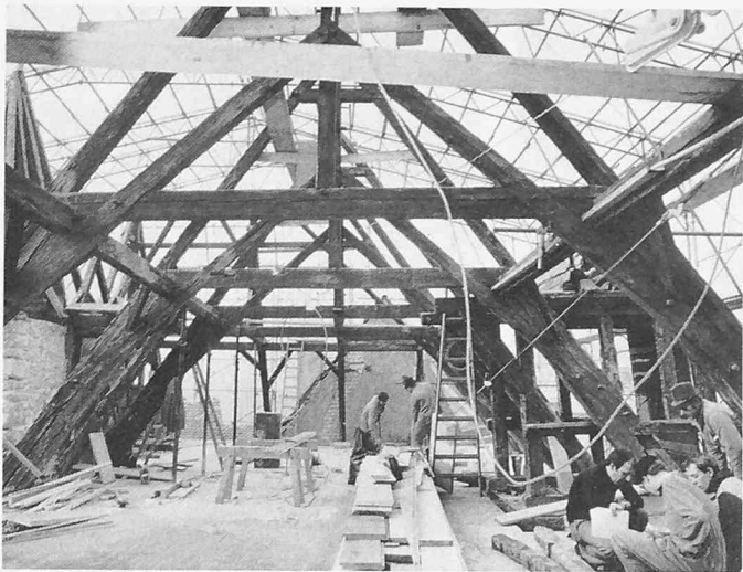
Dachstuhl aus der Zeit um 1500. Die wertvolle alte Konstruktion konnte erhalten und durch Ausräumen des Dachraumes sichtbar gemacht werden
