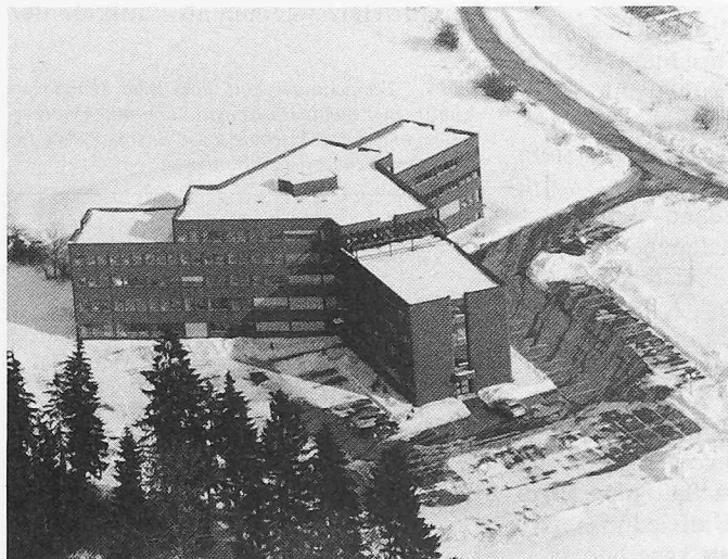
Bild 11. Das Verwaltungsgebäude mit einer Bürofläche von 5000 m 2 wird ohne jede Zusatzheizung monovalent mit dem Massivabsorber-Heizsystem beheizt
