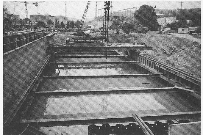
Bild 3. In bestimmten Arbeitsetappen werden Bauteile geflutet
