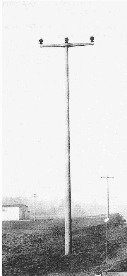
20-kV-Einfachleitung (Tragmast, L = 10\text{--}12\text{ m} )
