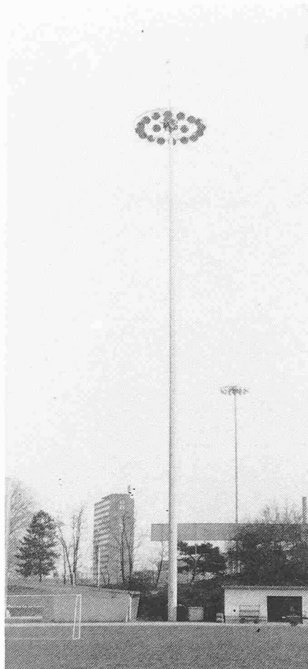
Beispiel eines Schleuderbetonmastes: Beleuchtungsmast (Länge: bis 45 m)
