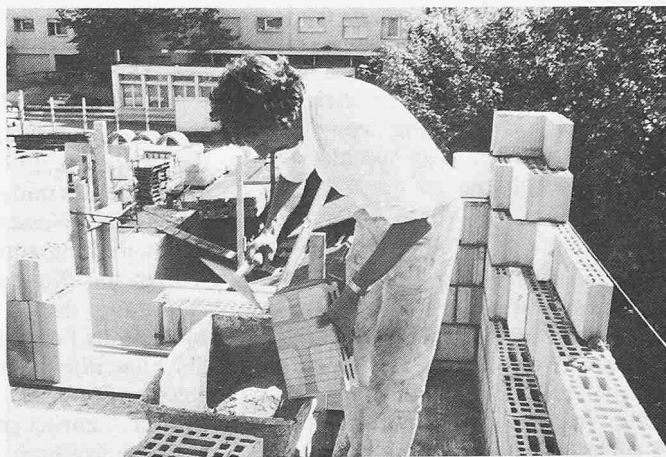
Bild 5. Der Mauermörtel soll gerade nass, dass er an der Kelle nicht klebt, und gerade trocken, dass er an den Steinen haftet, sein
