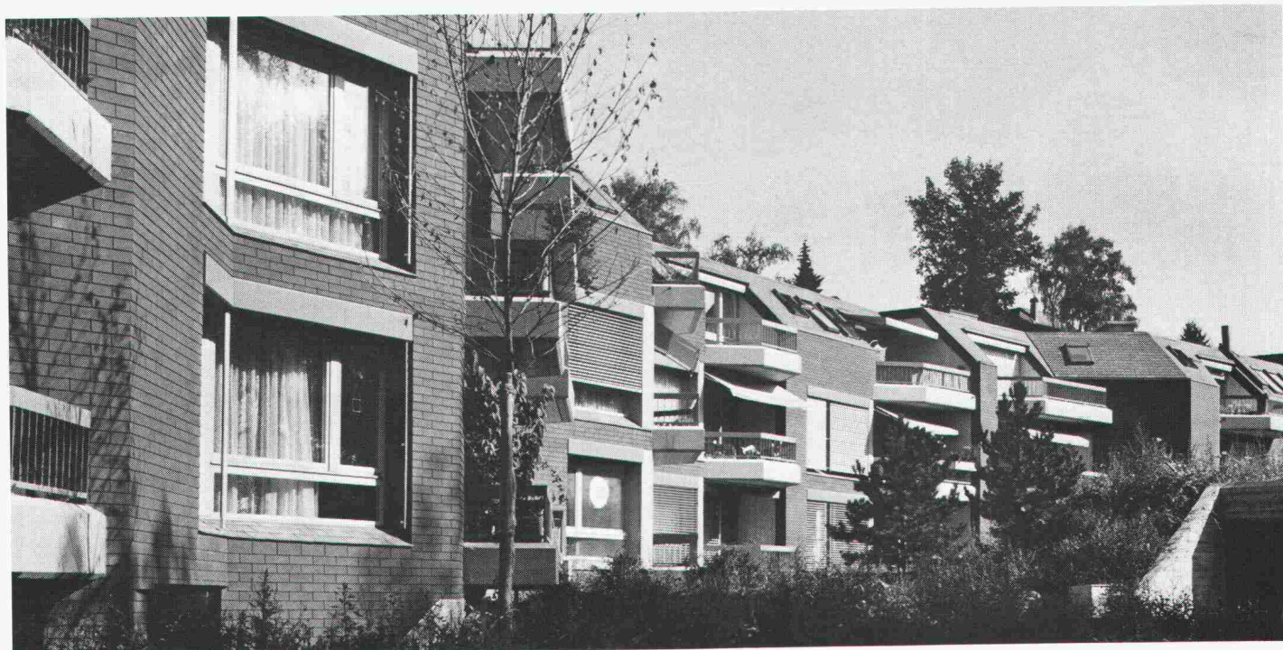
Wohnsiedlung Dalmaziquai in Bern, Doppeldeckung 20×30 cm, Braun SC 49
