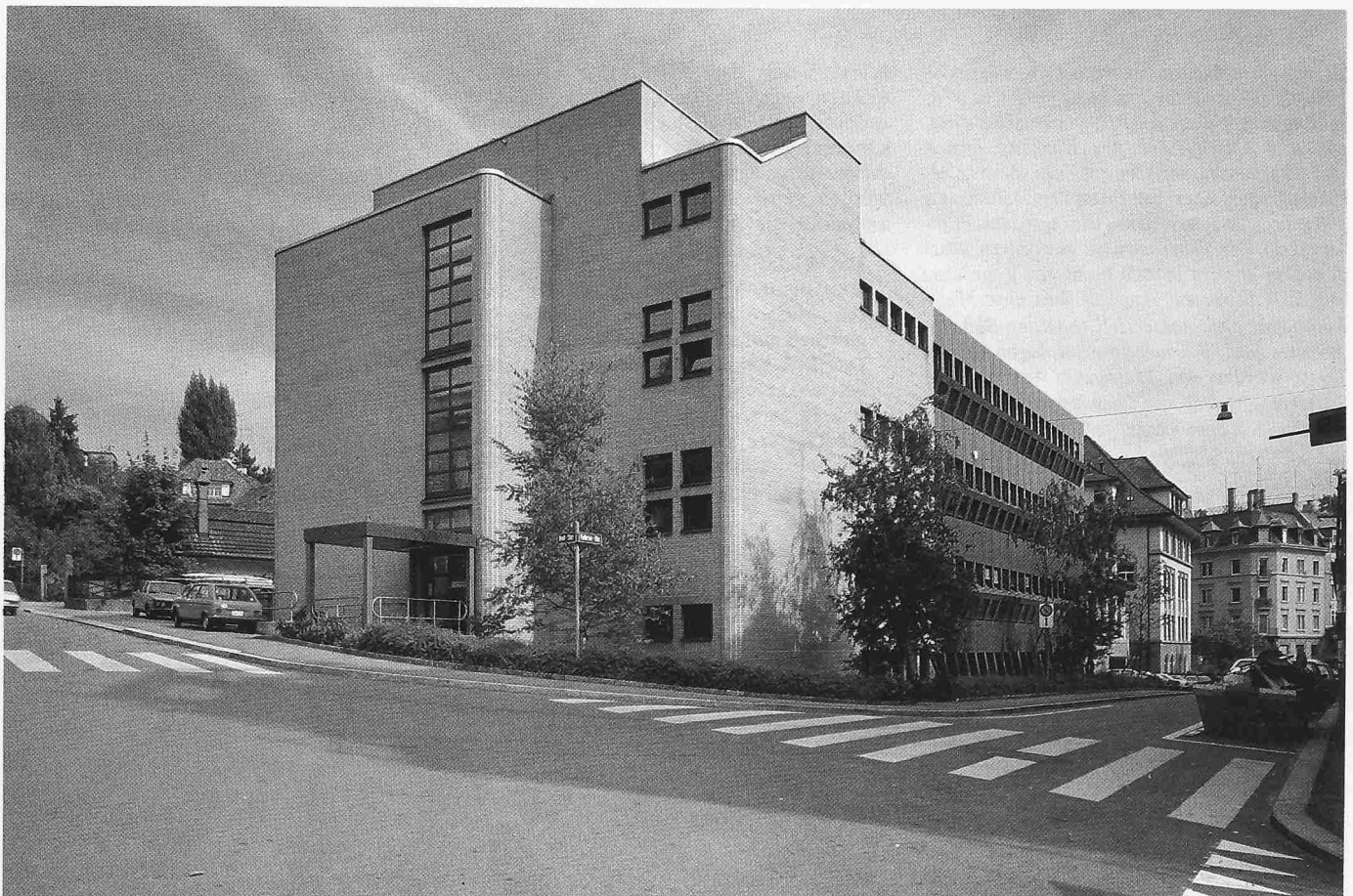
Kantonales Chemisches Laboratorium. Ansicht von Westen
