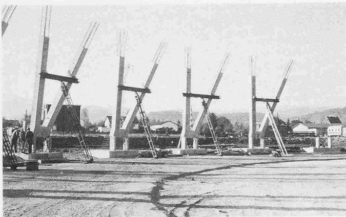
Bild 10. Rüstung des unteren Tragringes
