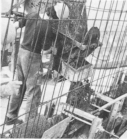
Bild 13. Einbringen von Beton
