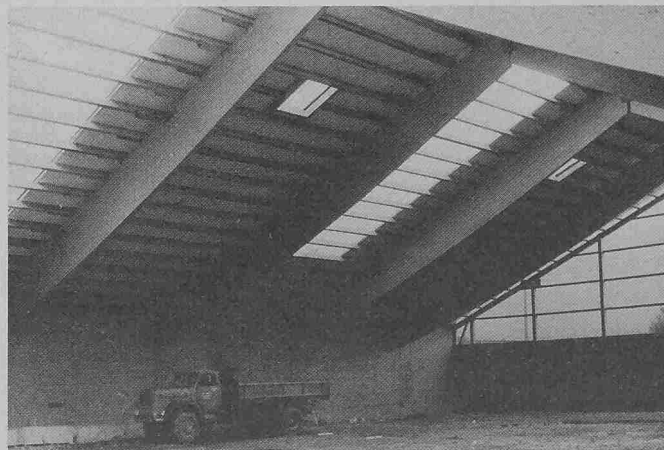
Tennishalle Bad Ragaz mit Gantner Isolier-Unterdach
