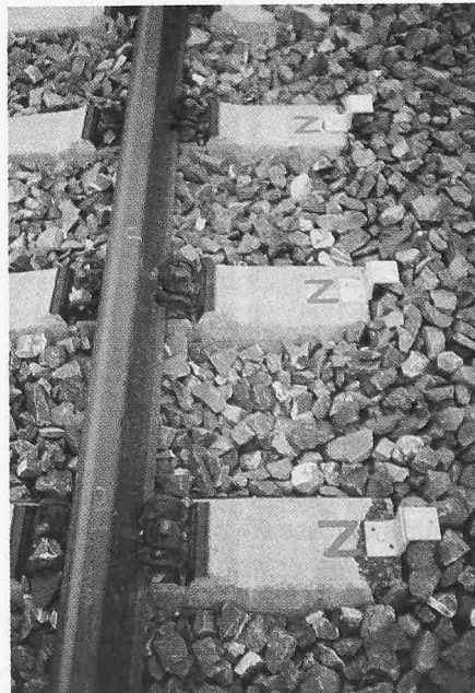
Bild 4. Messpunkte für Einsenkungsmessung
