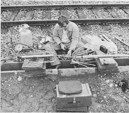
Bild 10. Kabelmonteur bei der Spleissarbeit
