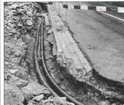
11.55 Komplett verlegt – 360 m nahtlose Fernwärmeleitung – Ziel erreicht!
