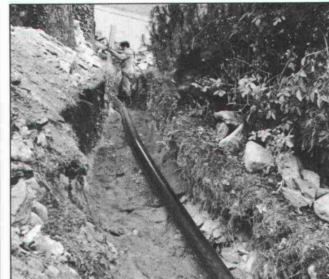
10.45 Die erste Länge ist verlegt...
