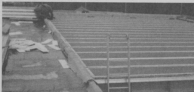
DLW-Dachelemente Typ T 90/75 als Verwendung für Flachdachkonstruktion
