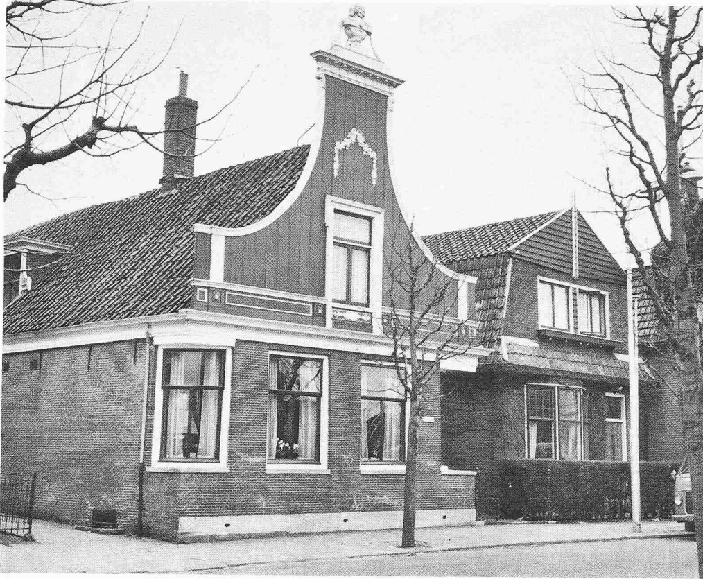
Hausfassade in Zaandijk (Holland). Glockengiebelhaus 17. Jh. Typ Glockengiebel. Ausdrucksmöglichkeit der Baumeister in der Formation der Fassade (Italienischer Einfluss)
