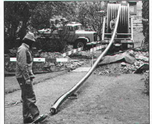
10.04 Die Verlegung der FLEXWELL-Leitung beginnt...
