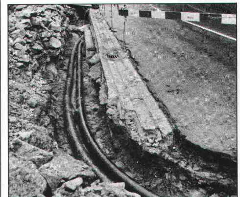
11.55 Komplett verlegt – 360 m nahtlose Fernwärmeleitung – Ziel erreicht!
