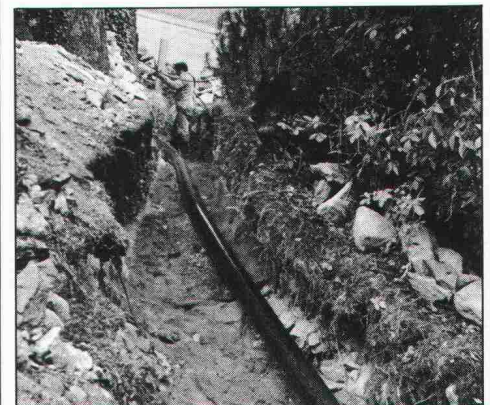
10.45 Die erste Länge ist verlegt...
