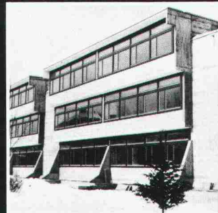
Erdbebensichere Lagerung eines Schulhauses in Jugo- slawien (Einweihung 1969).
