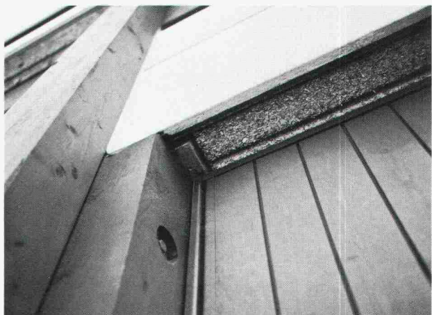
Detail Mehrzweckhalle, Haag SG
