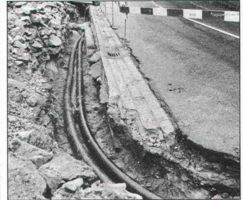
11.55 Komplett verlegt – 360 m nahtlose Fernwärmeleitung – Ziel erreicht!
