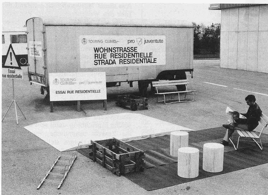
Die Elemente des Wohnstrassen-Sets bestehen aus Rampen zur Konstruktion von Schwellen, Rosten zum Herstellen simulierter Blumentröge, Holzblöcken für Abgrenzungen, Bänken, Rasenmatten, Baumattrappen usw. Der Massstab 1:1 ermöglicht eine wirklichkeitsgetreue Darstellung einer Wohnstrasse
