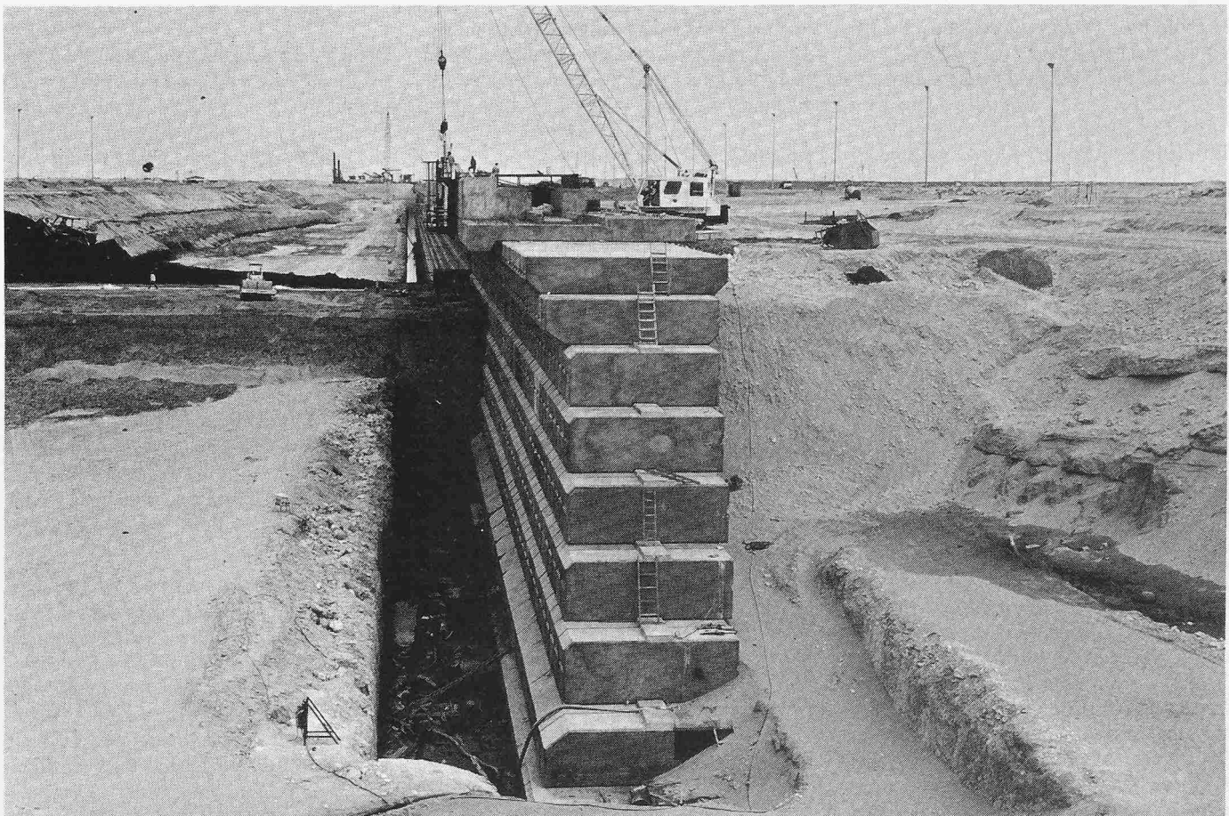
Bild 18. Hafenanlage Jebel Ali. Total 1,5 Mio. m³ Beton
