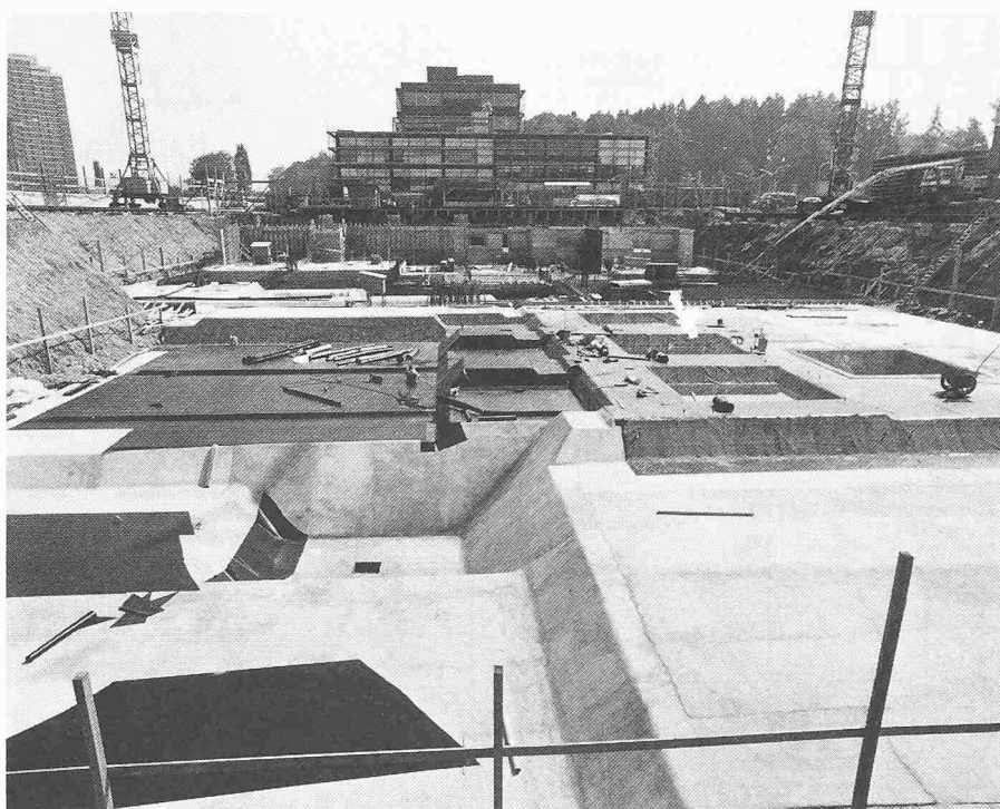
Offene Baugrube und Aussenabdichtung bei der Volksbank Bern, 2-Lagen-Prüfsystem; von unten nach oben: Unterlagsboden mit Zementglattstrich, Verlegen der Abdichtungen, Schutzschicht, Armierung, Bodenplatte, aufgehende Wände
