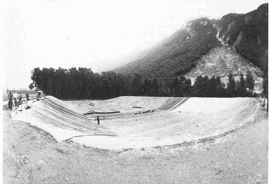
Bild 11. Blick auf die mit Kunststoffdichtungsbahnen fertig abgedichtete erste Etappe der gesicherten Deponie in Collombey-Muraz
