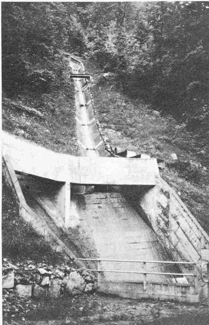
Bild 9. Chellbach. Ortbetongerinne mit hundertprozentigem Gefälle und Kiessammler
