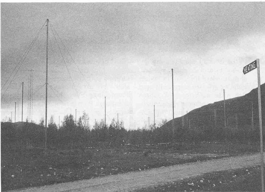
In einem weitläufigen Birkenhain des Ramfjordmoen-Tals steht ein «Wald» von Antennen: Die gekreuzten Dipole der Heating-Sendeanlage. Jedes Antennenfeld umfasst 36 gekreuzte Dipole, und drei Antennenfelder stehen zur Verfügung. Durch Phasensteuerung lässt sich die Richtung des Sendestrahlens schwenken
