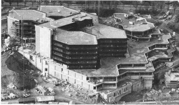
SKA-Neubau Uetlihof Zürich 28'000 m 2 Sarnafil
