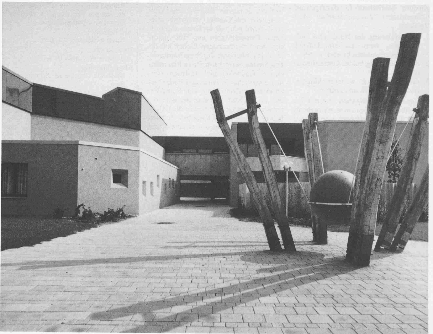
Zugang von Norden, mit Plastik von Walter Kretz, Bern
