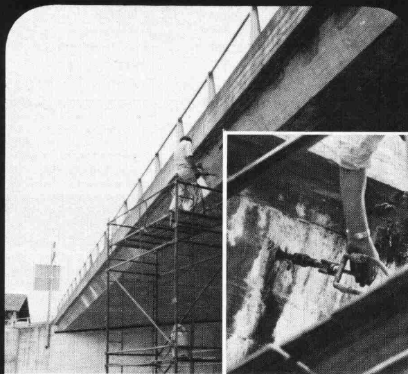
Risse in Betonbauwerken Abdichtung mit Renesco-Flexin-Injektionen
