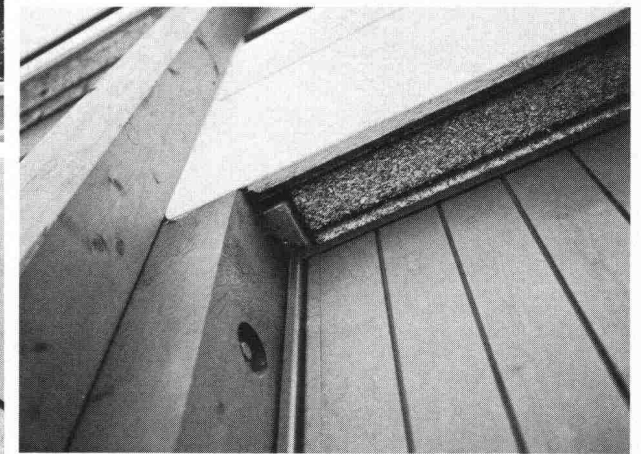
Detail Mehrzweckhalle, Haag SG
