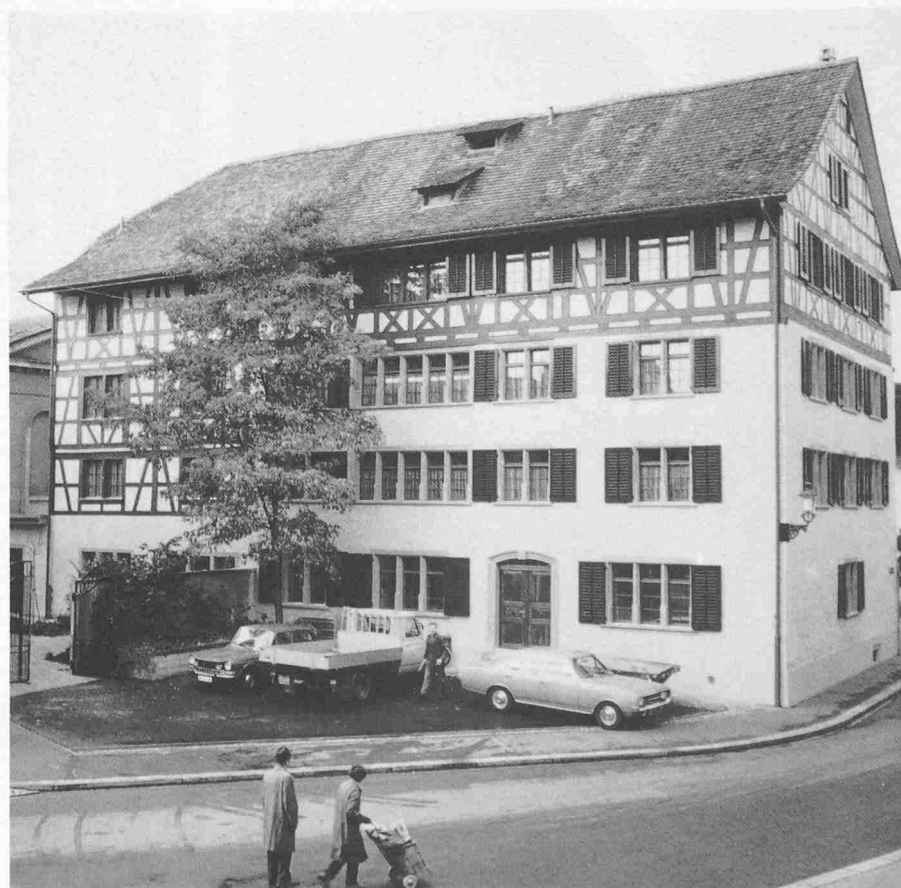
Die Ostfassade vor der Restaurierung
