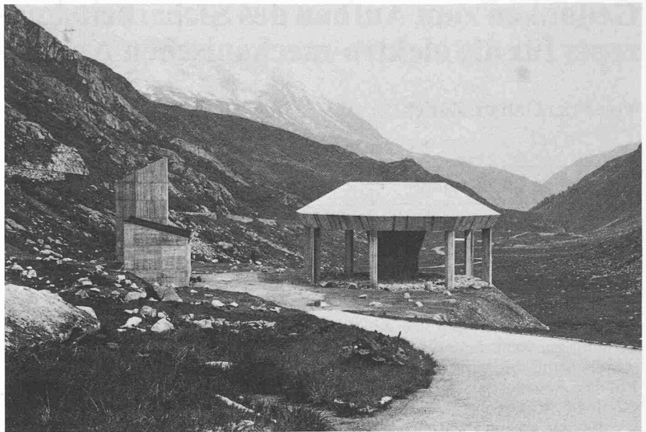
Bild 3. Aussenbauwerk Guspisbach, Ansicht von Süden
