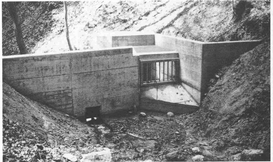
Bild 13. Talsperrenabschluss Bünnenbäche und Einlaufbauwerk Wirbelfallschacht
