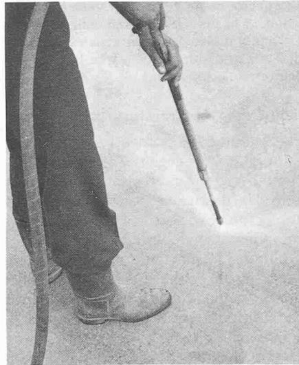
Bild 9. Reinigung der Betonoberfläche mit Hochdruckwasserstrahl (750 bar)
