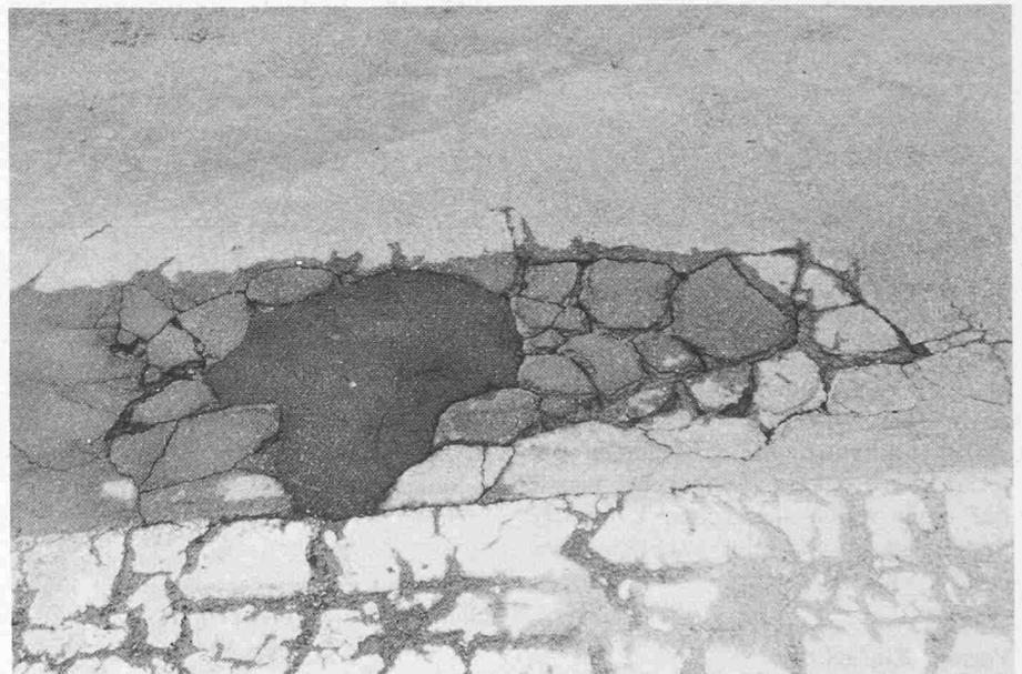
Bild 5. Durch nachgiebige (weiche) Unterlagen wurde dieser Walzasphalt nach wenigen Wintern zerstört
