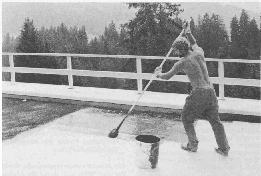
Bild 11. Auftragen der Abdichtung Efkaprene von Hand
