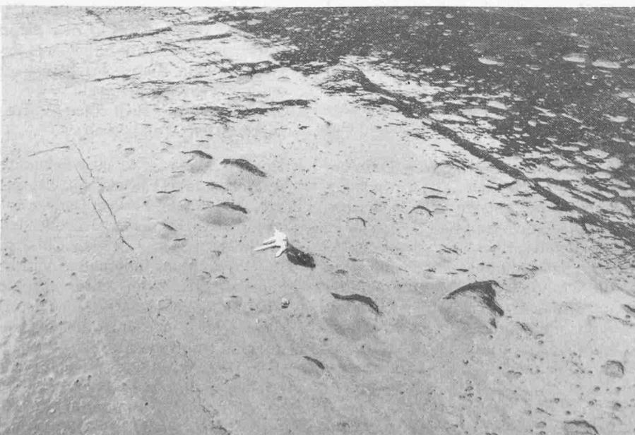
Bild 3. Blasen unter einer kunststoffmodifizierten Bitumenfolie
