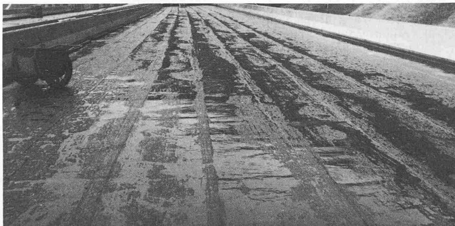
Bild 8. Überlappungen bei einer kunststoffmodifizierten Bitumenfolie bilden Wasserstau, der in den Hohlräumen des Walzasphaltes bleibt
