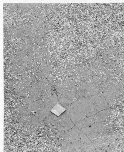
Bild 6. Durch eine weiche, dicke Abdichtung wurde dieser Gussasphalt schon im ersten Winter zerstört
