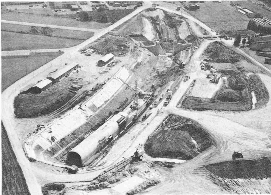
Bild 2. Los Süd: Flugaufnahme in Richtung Süd-Osten
