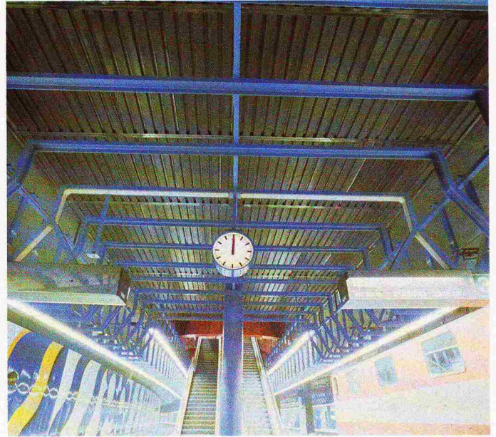
Bild 4. Rippenkonstruktion über dem Perrongeschoss
