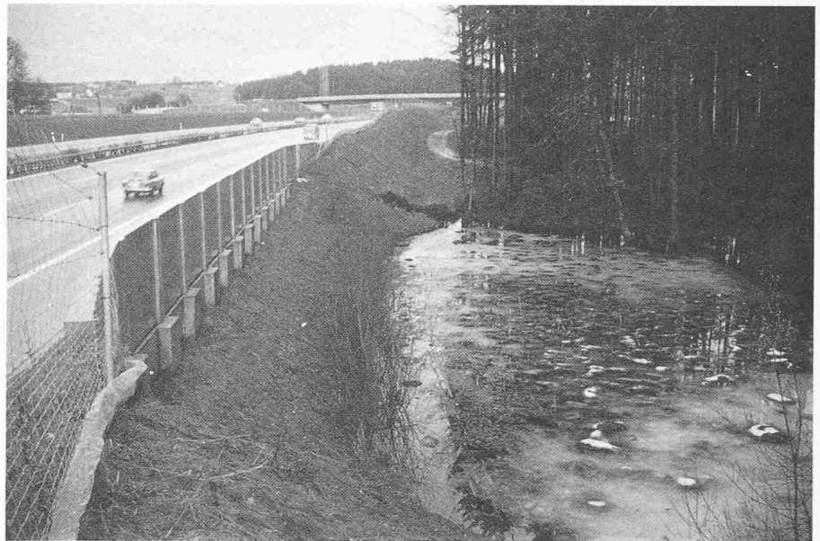
Bild 12. Vogelholz bei Effretikon (ZH). Erhaltung eines NSG neben der Autobahn durch Verpflanzung und Spundwand
