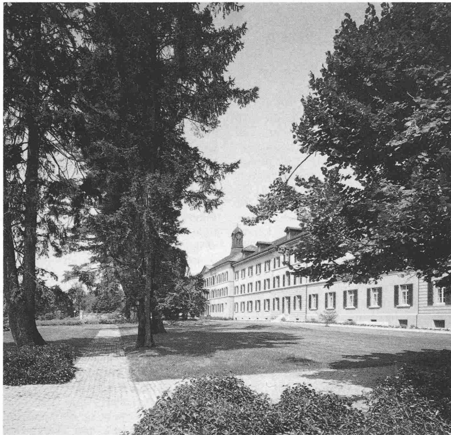
Ausschnitt Südfassade Ostteil
