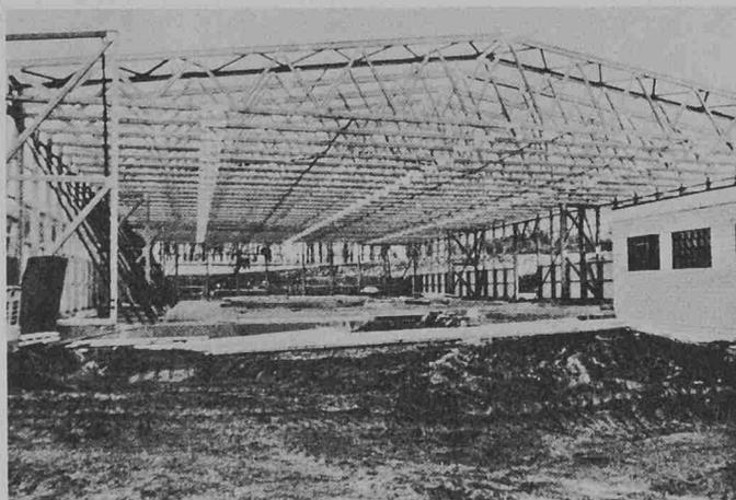
Doppeltrapezbindern mit einseitigem Kragarm, 2 m Mittenabstand und einer Gesamtspannweite von 36,24 m (einschliesslich des Vordaches auf einer Seite). Die freie Spannweite innen beträgt 29,32 m.
